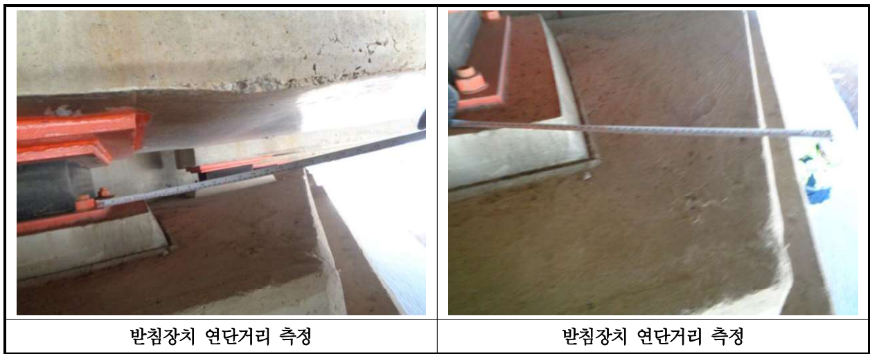
【사진 14.3.12】 교량받침장치 연단거리측정
