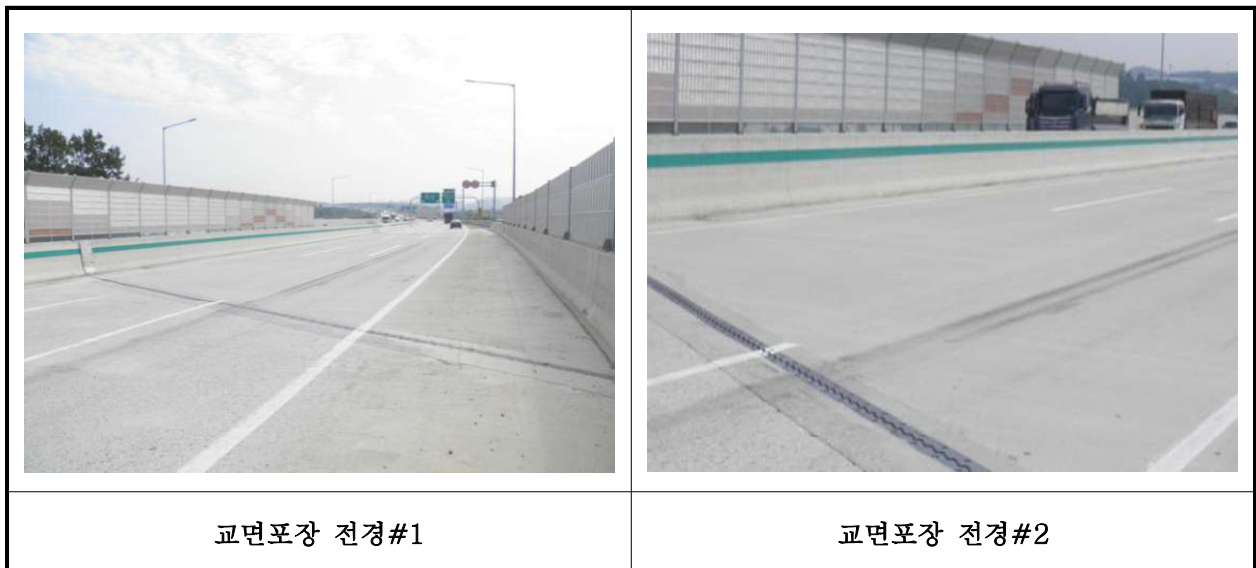
【사진 14.3.17】 교면포장 전경
