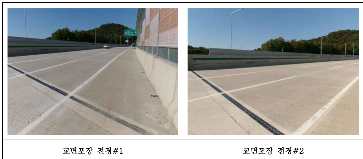
【사진 14.3.38】 교면포장 전경
