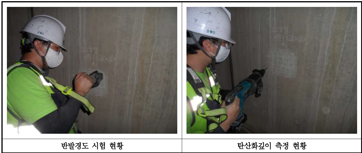
【사진 14.4.1】 콘크리트 내구성조사 현황
