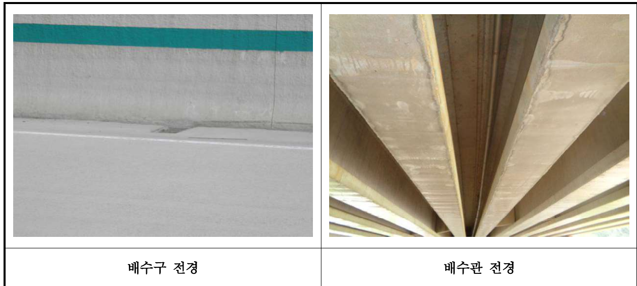
【사진 14.3.19】 배수시설 전경
