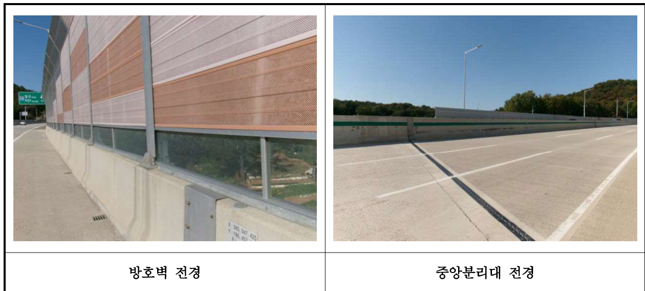
【사진 14.3.42】 방호벽 및 중앙분리대 전경
