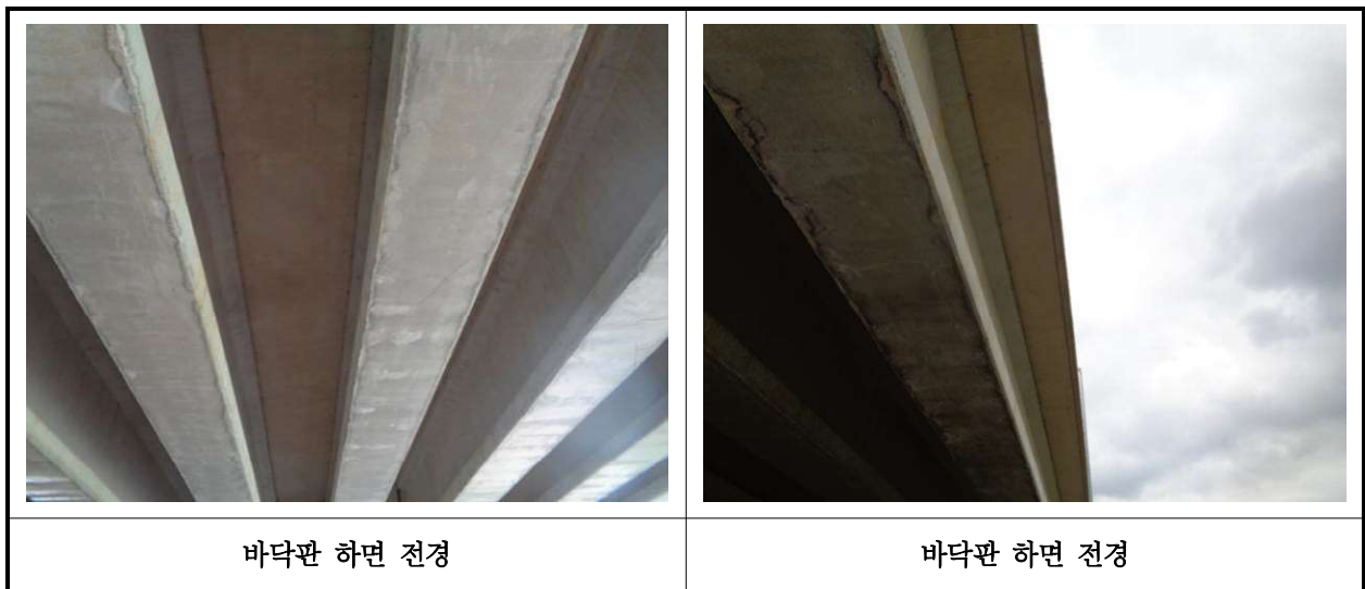
【사진 14.3.2】 바닥판하면 전경
