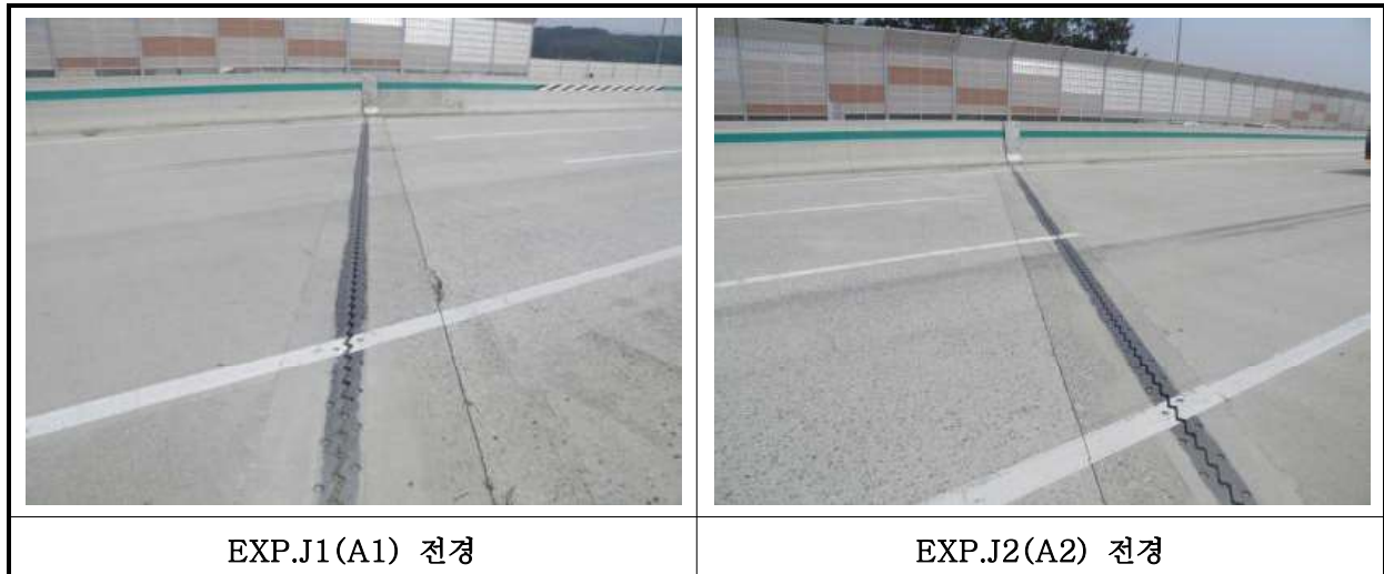
【사진 14.3.14】 신축이음장치 전경
