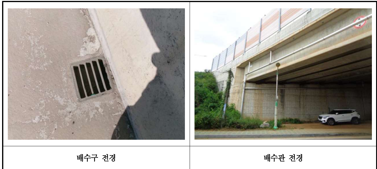
【사진 14.3.40】 배수시설 전경
