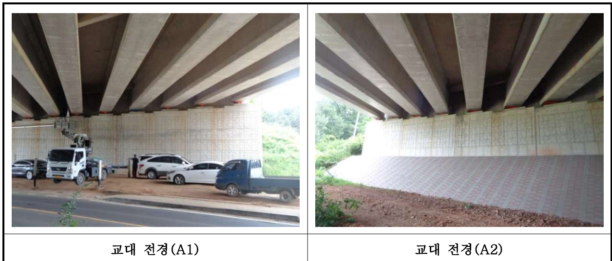
【사진 14.3.8】 교대 전경
