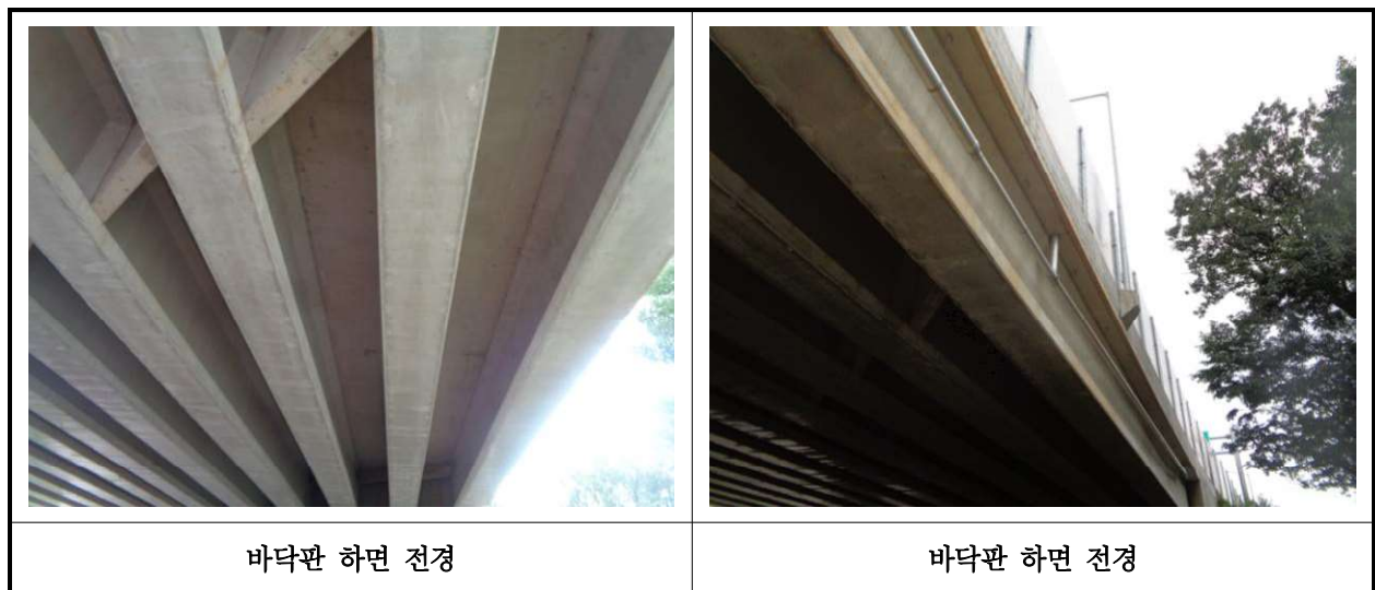
【사진 14.3.23】 바닥판하면 전경
