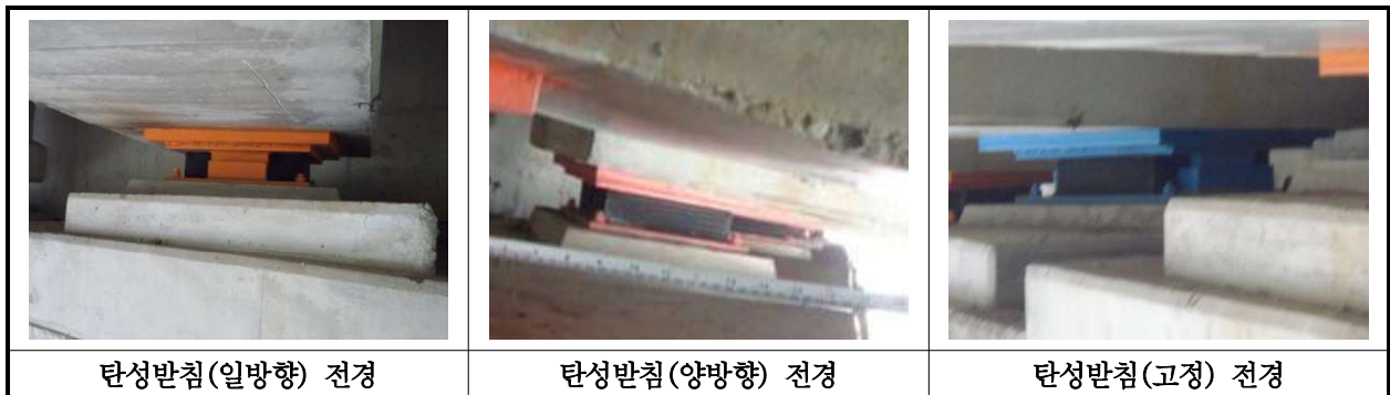
【사진 14.3.31】 교량받침 전경
