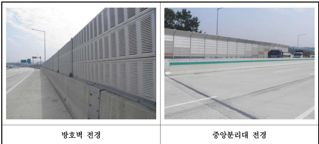
【사진 14.3.21】 방호벽 및 중앙분리대 전경
