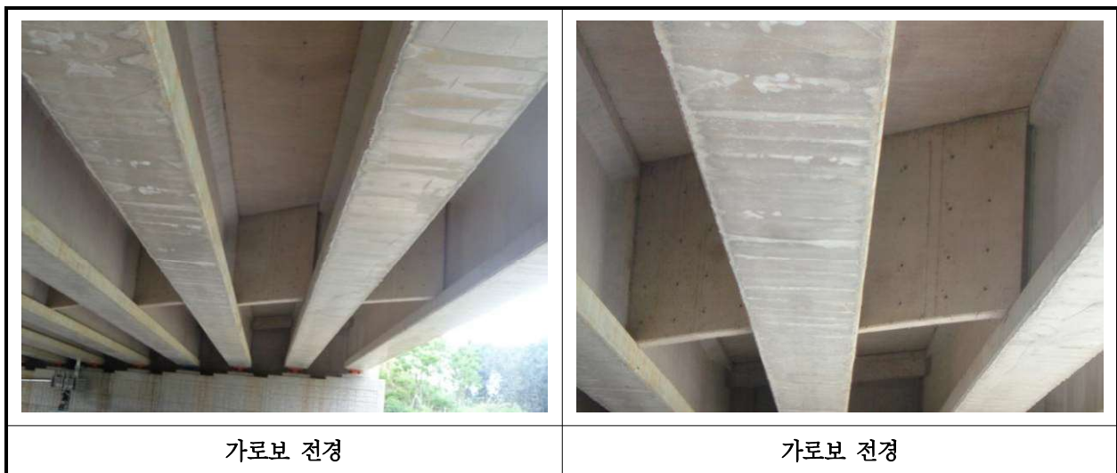
【사진 14.3.6】 가로보 전경
